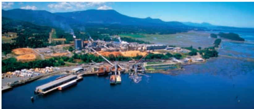
長年、省エネルギー/環境管理に積極的に取り組んできたバンクーバー島のクロフトン工場。化石燃料の代替として木質廃棄物の本格利用を推進してきた実績を誇ります。
