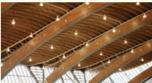
先進の木造技術を駆使したオリンピック・オーバル。ユニークな小屋組は総木造。世界有数のスパン長を誇る
